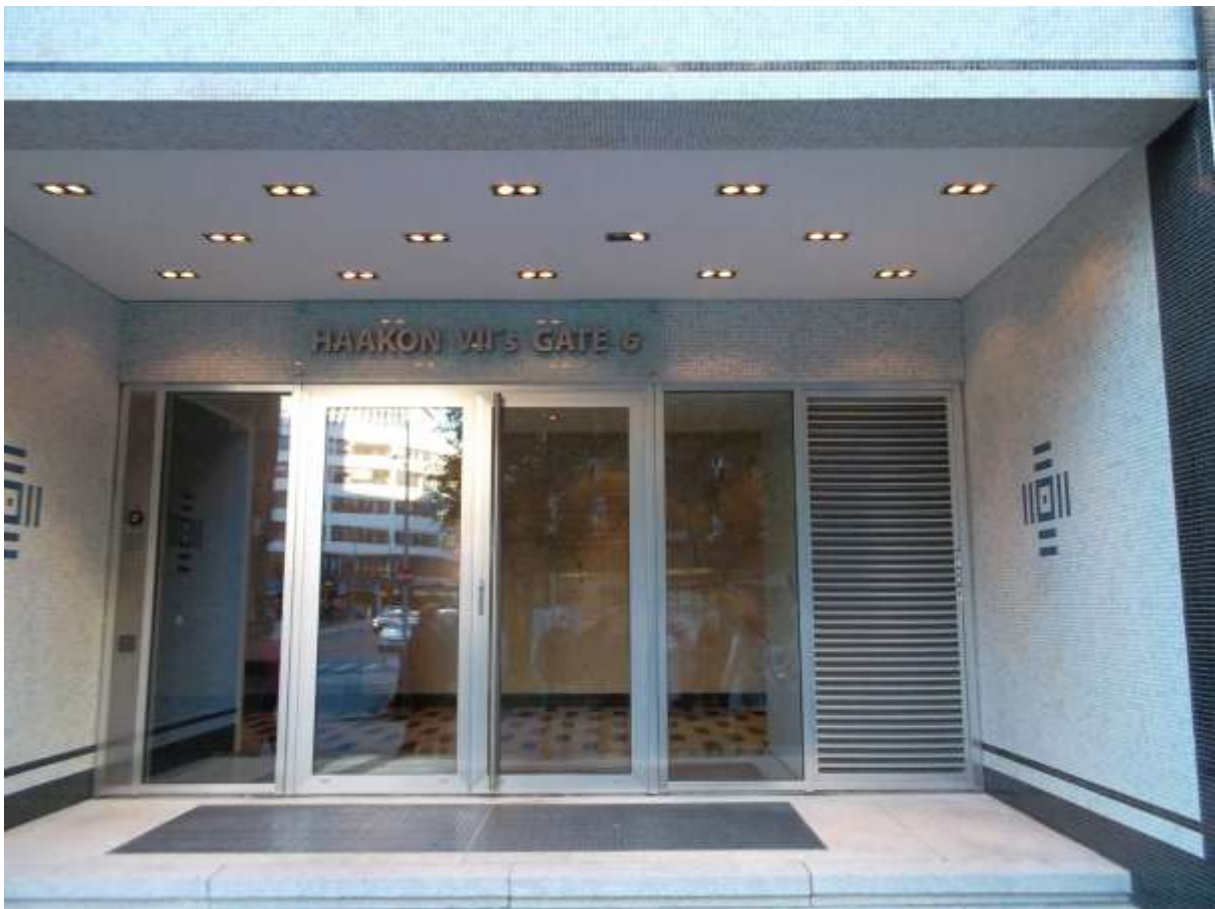
Inngangsparti til de nye NTF-lokalene i Oslo.
